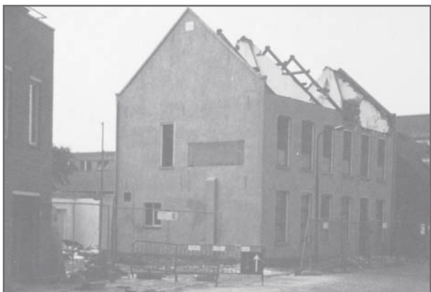
Afbraak kantoor- en woonhuis . . .
