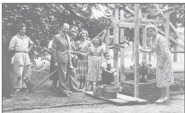
Bouwfoto van de poort
